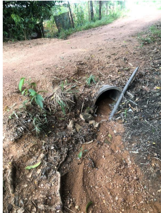
Foto 53. Manilha no encontro da estrada de terra e a drenagem afluyente direita do Ribeirão Mestre d'Armas. Nota-se a ausência de água.
